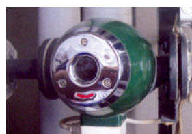
1953 prima pompa di ricircolo esente da manutenzione Wilo-Perfecta Standard da circa il 1960
